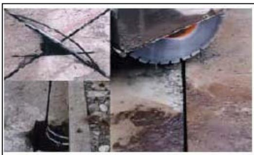
Fresatura terreno per inserimento cavi
