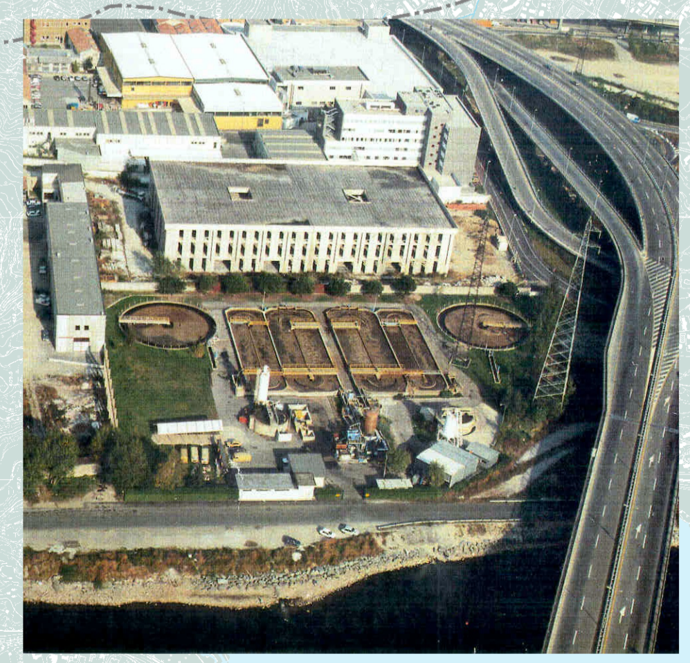
DEPURATORE COMUNALE DI LECCO ubicazione: via Buoizzi
